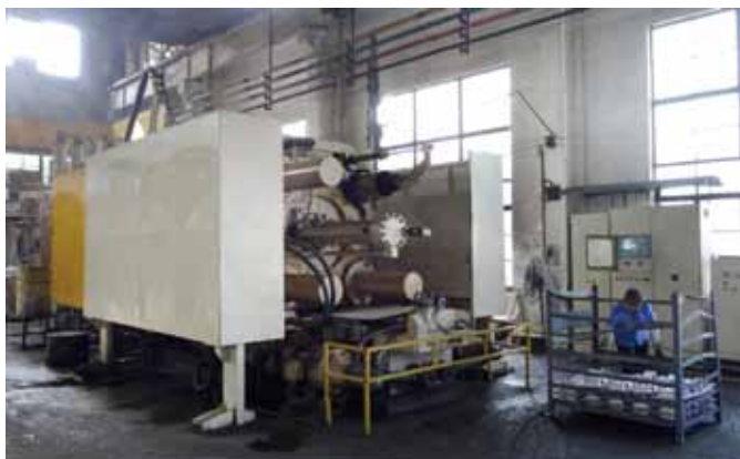
▲ 华阳变速公司压铸车间
